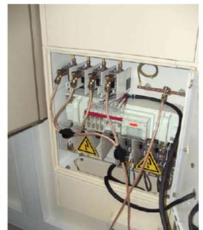
Toujours raccorder le \_\_\_\_\_ de raccorder les conducteurs
