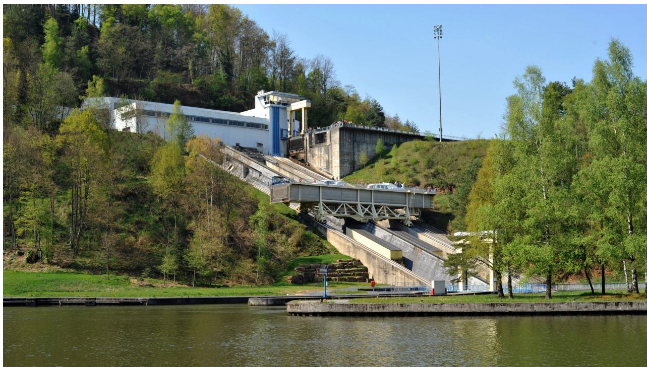
Ascenseur à bateaux de Saint-Louis-Arzviller
